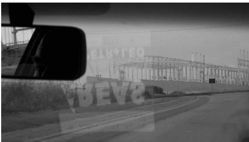
Instalações do estaleiro Jurong visto da estrada estadual ES-010, em direção ao sul do estado.
