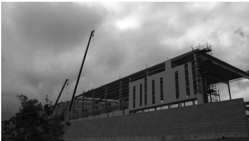
Estruturas do estaleiro Jurong vista da estrada direção sul-norte.
