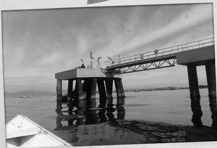
Terminal de regaseificação de GNL da Petrobras Baía de Guanabara/RJ - Joana Barros
