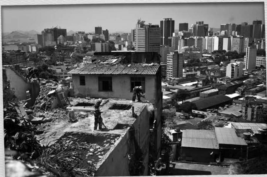
Demolição de casas no Morro da Providência
