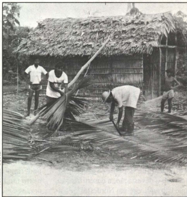
Construção de casa com palha de babaçu e ubim
